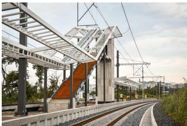
Obrázek 19 Výstavba zastávky Praha-Rajska zahrada 24
