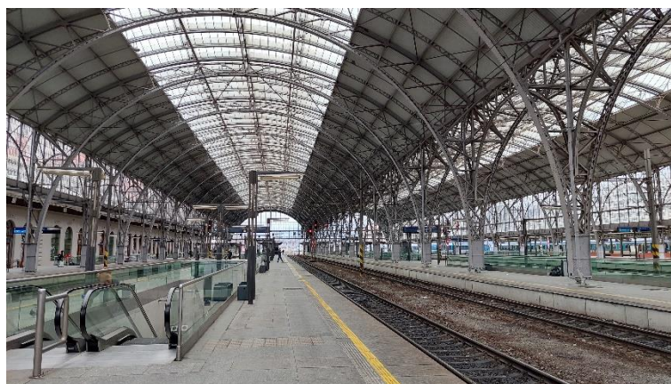
Fotografie 6 Zastřešení nástupišť
