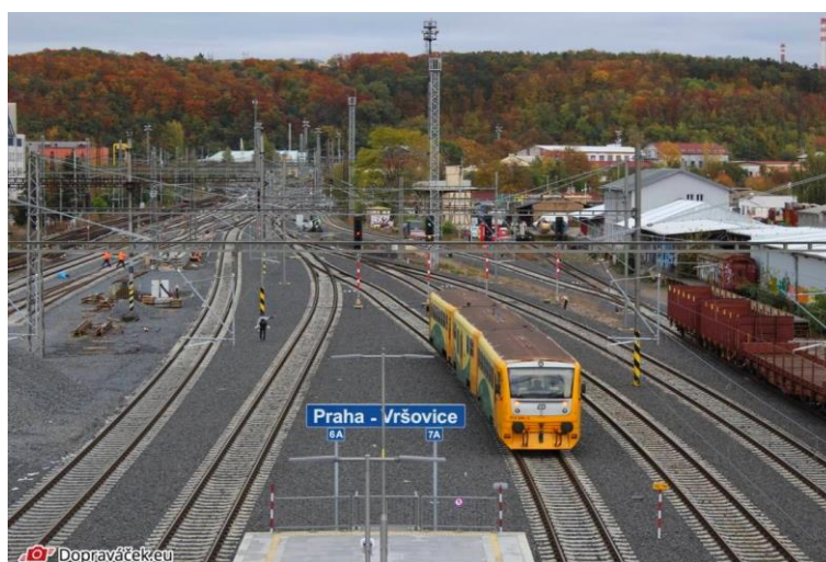
Obrázek 17 Zhlaví zmodernizované stanice Praha-Vršovice 21
