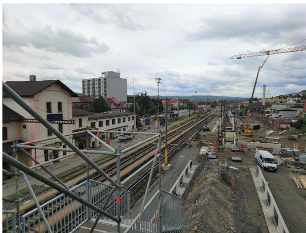
Obrázek 21 Rekonstrukce stanice Praha-Radotín 26
