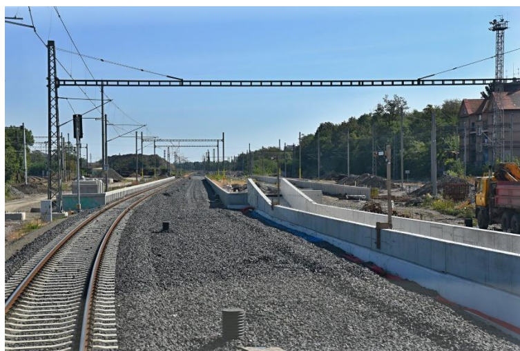
Obrázek 18 Modernizace IV. tranzitního koridoru 23
