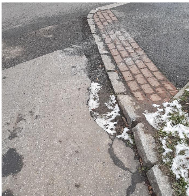
Fotografie 5: Olamování silnice u obrubníku
