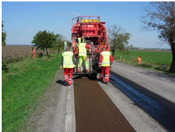
Obrázek 2: Oprava vyjetých kolejí 2
