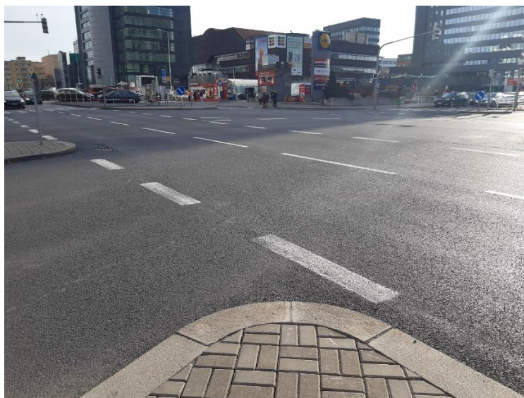
Fotografie 6: Vozovka po rekonstrukci
