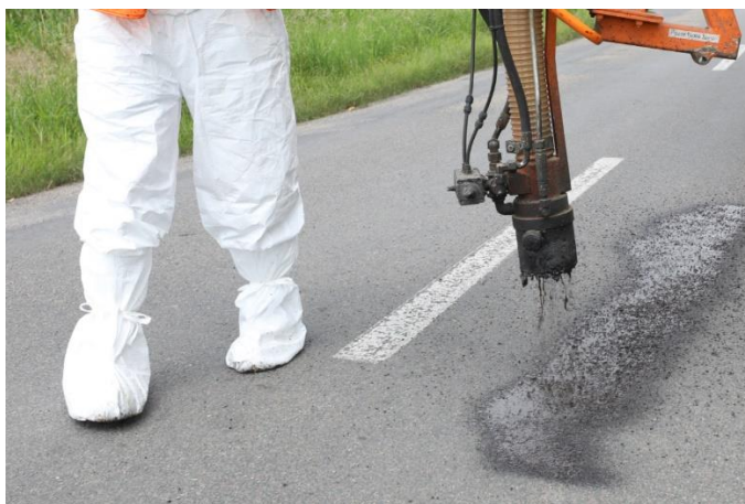
Obrázek 1: Vyspráva drobných trhlin 1
