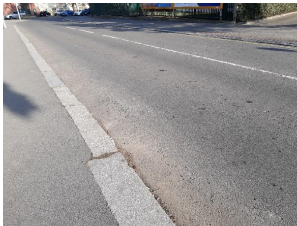
Fotografie 1: Vyhlazení povrchu vozovky
