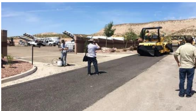
Obrázek 7: Asfaltová silnice s příměsí plastu 12
