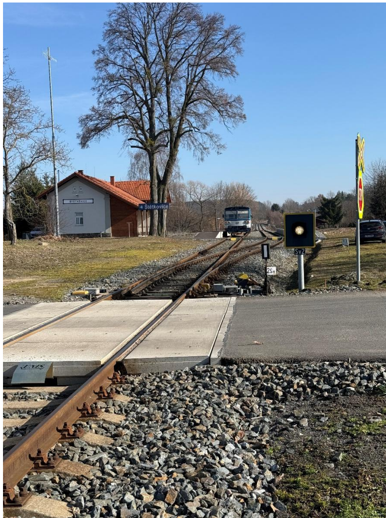
Fotografie 15 - Návěstidlo výhybky se samovratným přestavníkem v dopavně D3 Štětkovice
