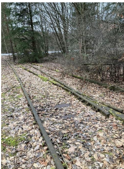
Fotografie 2: Výhybka v zastávce s nákladištěm Trojany
