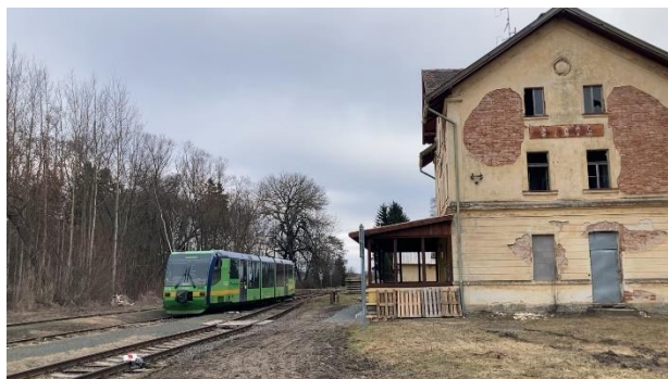
Fotografie 11: Staniční budova v Čisté a MJ Regiosprinter
