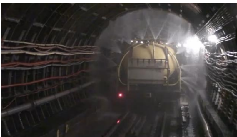
Obrázek 11 - Oplachování tunelu unikátním strojem
