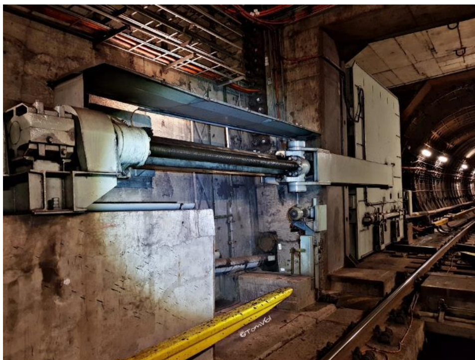
Příloha 5 - elektromotor a převodovka uzávěru
