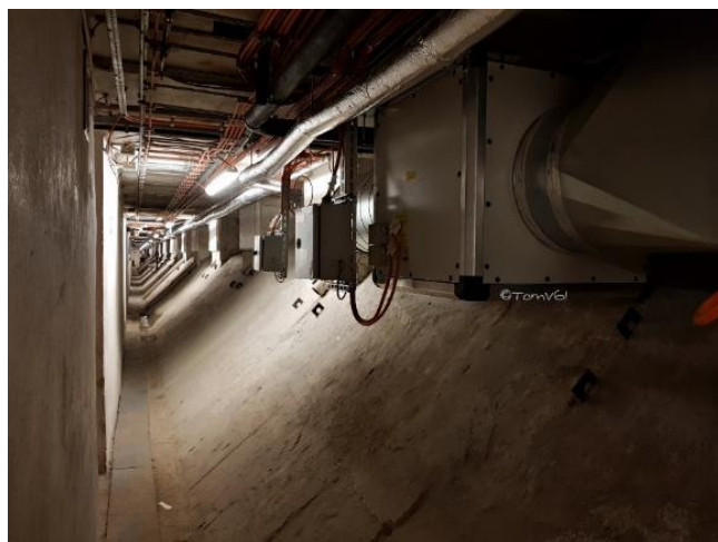
Foto 18 - Prostory pod nástupištěm trojlodní stanice
