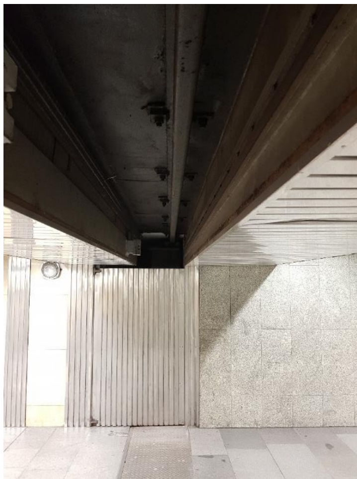
Příloha 17 - Horní pojezdová kolejnice u ZT115
