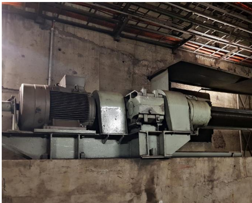
Příloha 5 - elektromotor a převodovka uzávěru
