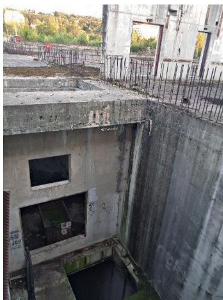
Foto 27 - Betonové základy a kus podzemní sekce
