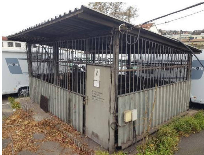
Foto 22 - Nenápadný vstup do podzemního vodního díla
