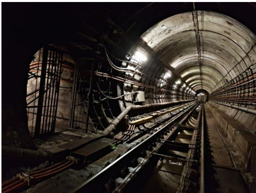
Příloha 9 - vstup do hygibuňky z tunelu
