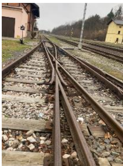
Obrázek 53, trojcestná výhybka 9,10
