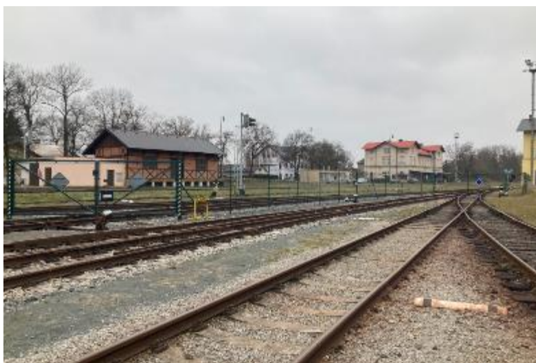
Obrázek 66, pohled do stanice, (zleva) skladiště, restaurace, výpravní budova, vodárna
