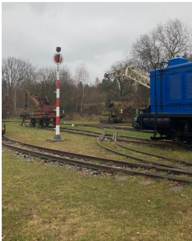
Obrázek 38, unikátní úrovnňové křižení úzkorozchodné a normálně rozchodné železnice s příslušným návěstidlem převezené z Poldi Kladno v areálu muzea
