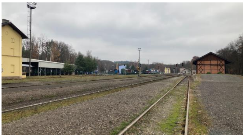
Obrázek 50, pohled směrem do depa, vpravo hrázdné skladiště, vlevo vodárna
