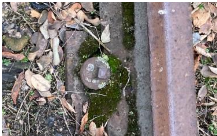
Obrázek 42, detail uchycení kolejnice u koleje č. 7
