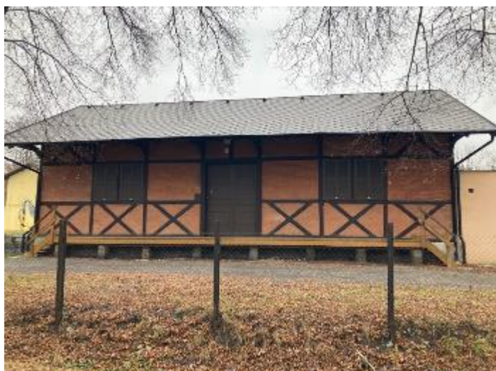
Obrázek 12, hrázdné skladiště, v pozadí opravená budova vodárny
