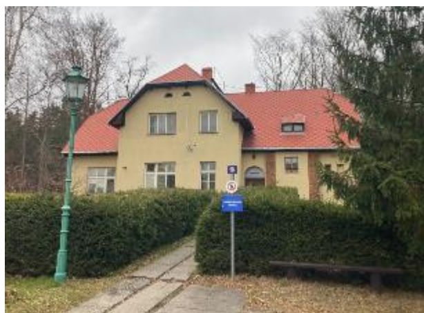
Obrázek 62, administrativní budova dnes
