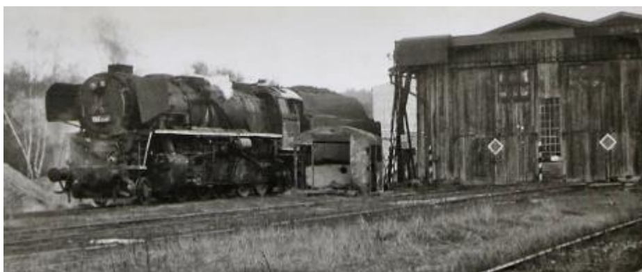
Obrázek 20, revizní hala s jeřábem, lokomotiva řady 556
