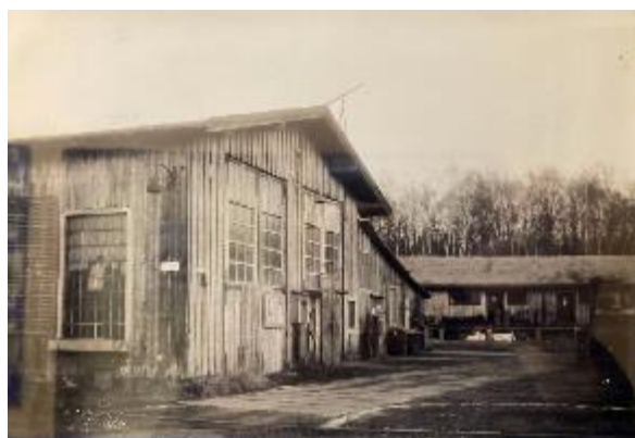
Obrázek 17, revizní dílna se skladištěm v pozadí (pohled od současného vstupu)
