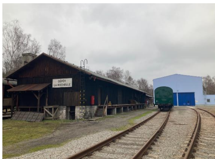
Obrázek 22, skladiště v pozadí se současnou halou
