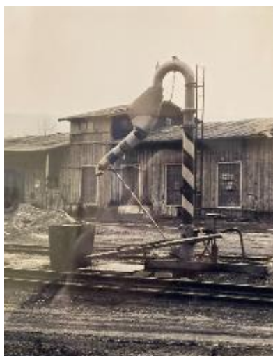
Obrázek 19, pohled od zauhlovacích jeřábů s dodnes stojícím vodním jeřábem
