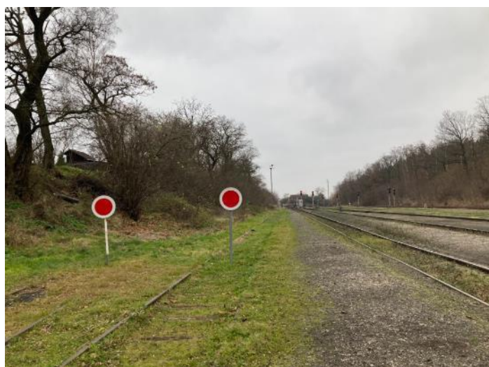
Obrázek 41, koleje č. 7,9 vybavené ručními návěstmi stůj, pohled směr Rakovník/Chomutov
