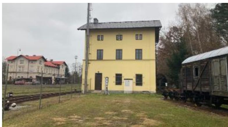
Obrázek 67, (zleva) výpr. budova, staniční koleje, vodárna, kolej za vodárnou s odstavenou sněhovou frézou
