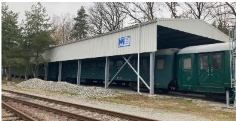
Obrázek 65, zastřešené koleje směrem k vodárně
