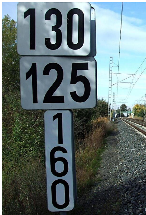
Obrázek 14: Svislý rychlostník „NS“ pro naklápěcí soupravy 13
