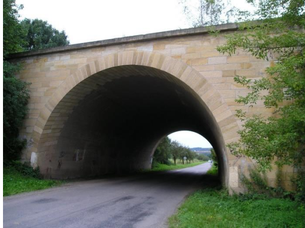
Obrázek 6: Těleso dálničního mostu u Jevíčka 6
