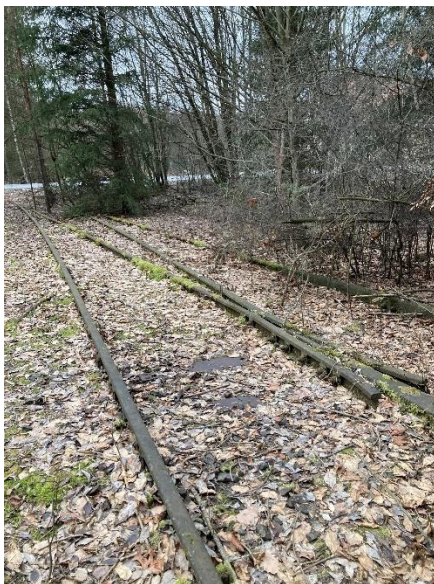
Fotografie 2: Výhybka v zastávce s nákladištěm Trojany
