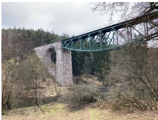
Fotografie 3: Most přes údolí Javornice
